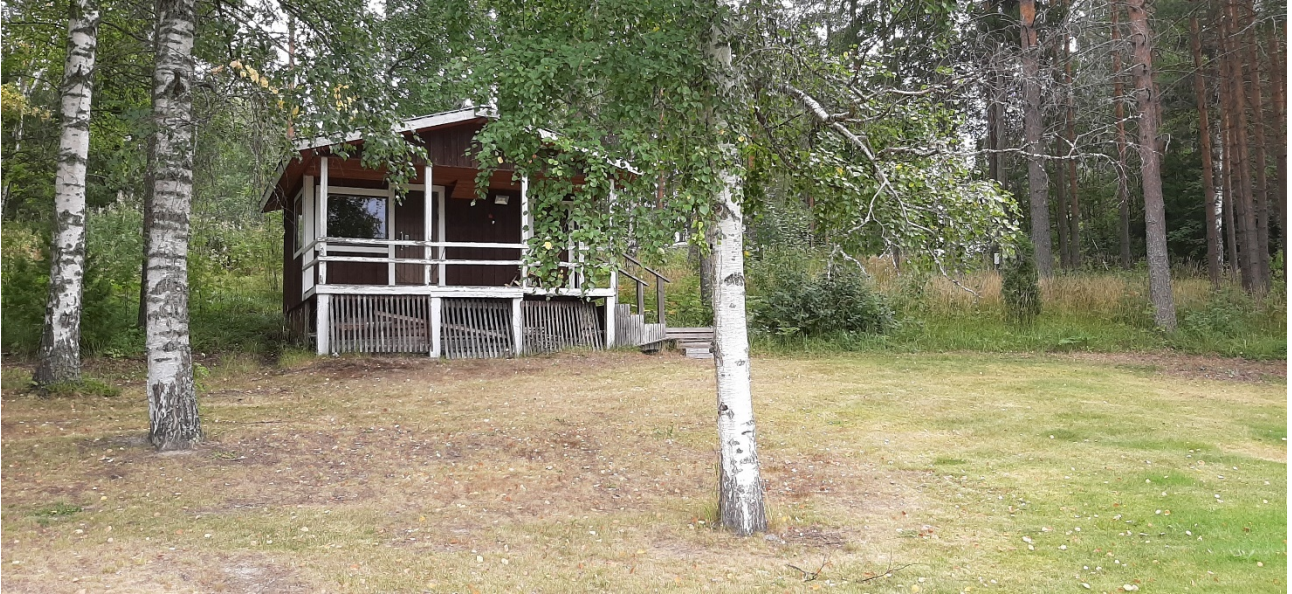
Kaislarannan tilan toinen purettava aitta tilan pohjoisosassa.
